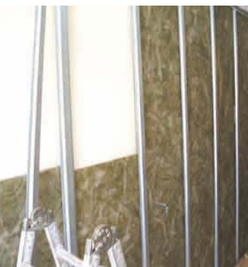
Detalle de colocación del arena óptima en la estructura metálica
