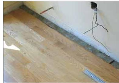
Se procede al relleno del hueco con una banda de lana Arena Óptima o con cinta de caucho con el fin de reducir la trasmisión de ruido del suelo a la nueva pared
