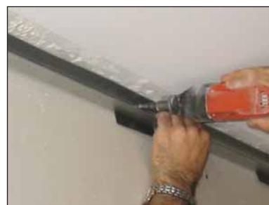
**3** Procedemos a colocar en el perímetro de la pared el canal en U, taladrando los dos elementos
