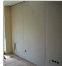
11 La pared está terminada a falta del relleno de las juntas mediante la pasta de rejuntable
