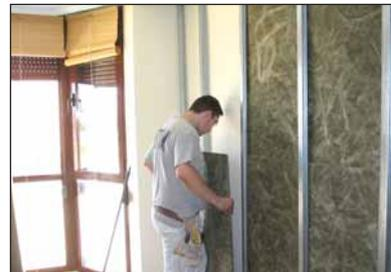
Se colocan los paneles de lana mineral Arena Óptima, deslizándolos en el espacio que queda entre la pared y las maestras verticales
