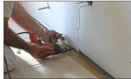
9 Si fuera necesario suplementar la altura de placa de yeso, se colocará una tira del mismo material en la parte inferior con el fin de que pueda ser tapada por el rodapie
