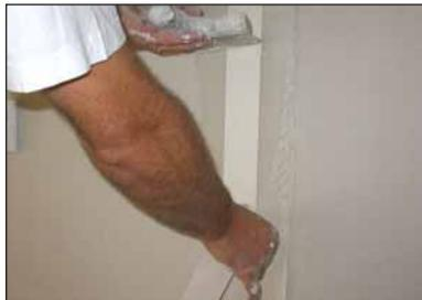
12 Se procede al relleno de las juntas y la colocación de la correspondiente cinta de rejuntado que impide que en el futuro aparezcan grietas. Después de una segunda capa de pasta en las juntas, la pared está lista para su tratamiento final: pintura, papel pintado, entelado, etc
