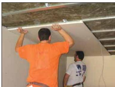
10 Comenzando por una esquina se colocan las placas de yeso laminado, que llevará las perforaciones necesarias para la instalación de los puntos de luz
