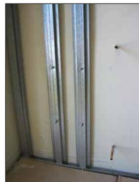
3 Se colocan dos maestras verticales a las cuales se les ha hecho pasar unos tornillos que nos servirán para anclar los soportes del radiador una vez colocada la placa de yeso
