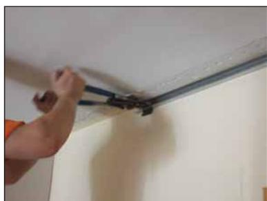
**4** Aseguramos mediante la colocación de remaches o tornillos
