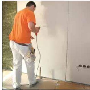
8 Las placas se colocan encima de la banda de material que se colocó en el suelo y se atornillan cada 30 cms a las maestras colocadas cada 600 mm. ó 400 mm
