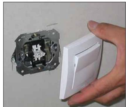
6 Se atornilla el mecanismo eléctrico a la caja y, después de pintar, se ajusta el escudo
