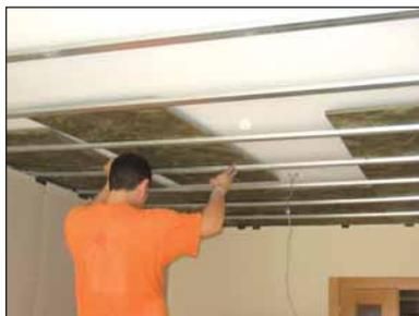
7 Colocamos los paneles de lana mineral Arena Óptima empleando como soporte las maestras ya instaladas
