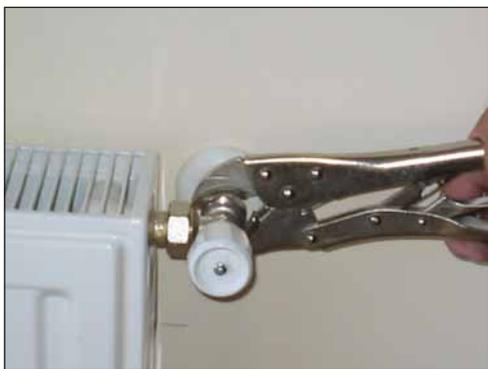
1 Si la pared a trasdosar tiene un radiador, previo vaciado de la instalación, procedemos a retirarlo, así como los soportes
