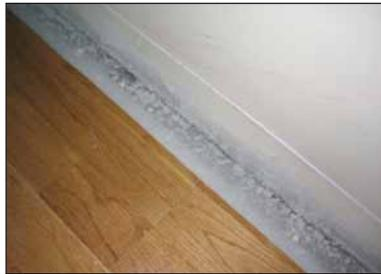
Retiramos el rodapié y la tira cortada, limpiando bien el hueco resultante, evitando que queden restos de yeso o cemento que dificulten el apoyo de los canales metálicos
