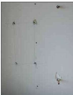
4 A la placa se la marcan los puntos por donde deben salir los tubos de cobre y los tornillos de sujeción de los soportes del radiador
