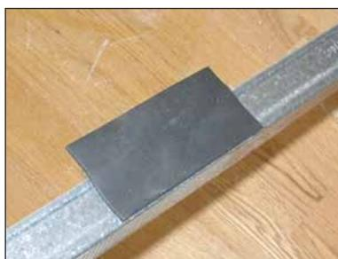
**2** Adherimos a los canales en U una cinta de caucho que servirá de amortiguador
