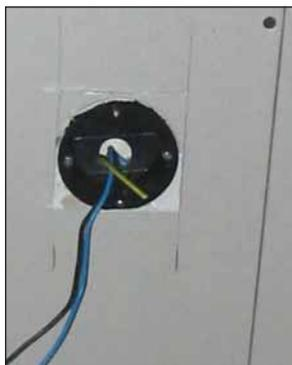
4 Una vez colocada la placa se extrae la lana sobrante y se instala la nueva caja que va a recibir el mecanismo eléctrico
