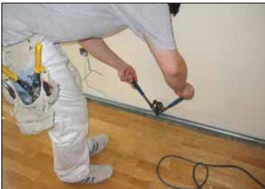
Sobre la banda y a un 1 mm aproximadamente de la pared soporte colocamos el canal en U y lo aseguramos al suelo por medio de remaches o tornillos
