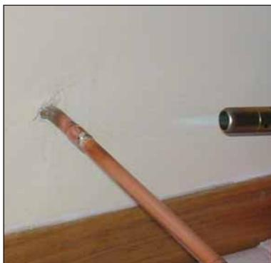
2 Soldamos una extensión de tubo de cobre al existente, para adaptarlo al grueso del nuevo tabique
