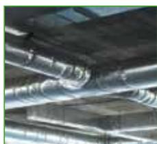
Aislamiento térmico para el exterior de conductos metálicos para la distribución de aire en la climatización. Manta de lana de vidrio, con revestimiento de aluminio reforzado.
