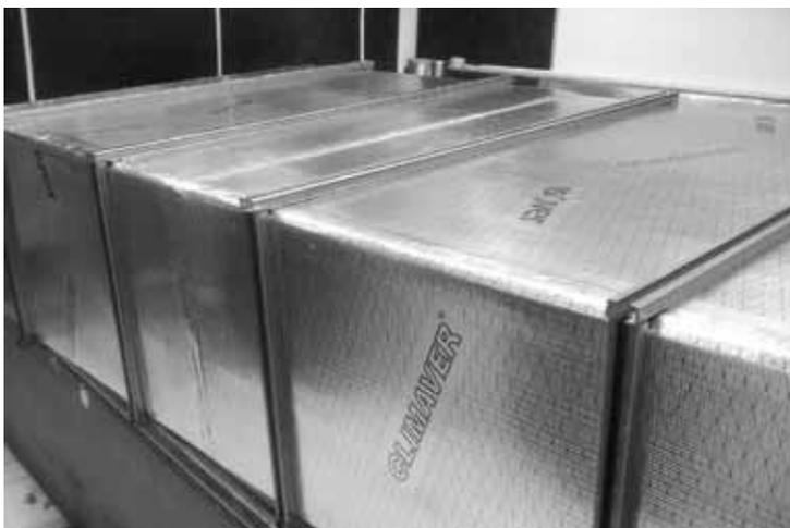
En el caso conductos de impulsión, en las esquinas, se dotará al carril de una escuadra de unión para evitar la separación de las caras perpendiculares entre sí. La parte superior e inferior del carril será suficientemente larga para cubrir los espesores de los carriles laterales.
