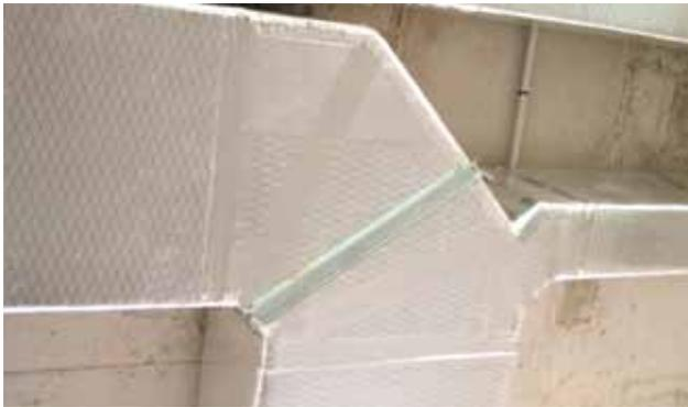
*LA INSTALACIÓN DE CONDUCTOS CLIMAVER PERMITE REDUCIR LAS PÉRDIDAS EN UN 70% RESPECTO A UN CONDUCTO DE CHAPA SIN AISLAR.*
