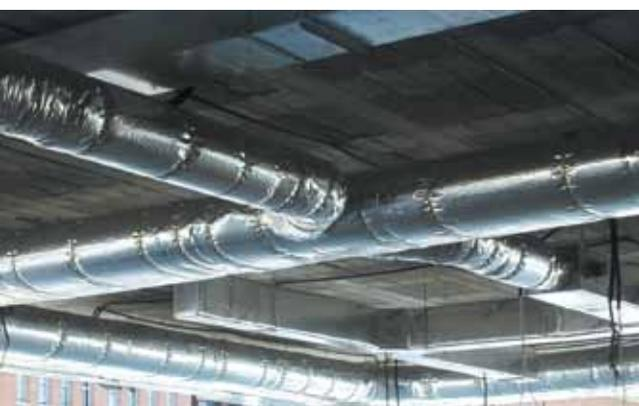
Se trata de conductos realizados a partir de planchas de chapa metálica (acero galvanizado o inoxidable, cobre, aluminio...), las cuales se cortan y se conforman para dar al conducto la geometría necesaria para la distribución de aire.
