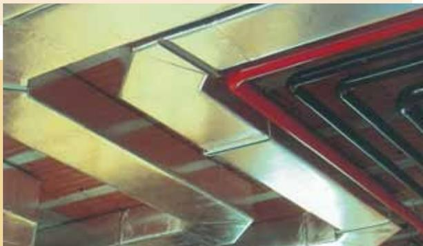
Son conductos realizados a partir de **paneles de lana de vidrio de alta densidad**, aglomerada con resinas termoendurecibles. El conducto se conforma a partir de estas planchas, cortándolas y doblándolas para obtener la sección deseada.
