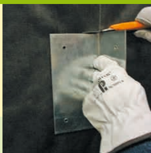
1 Corte del Ecovent ya instalado según el tamaño de la ménsula.
