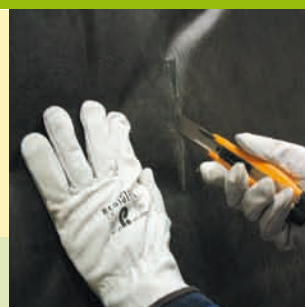
3 Corte del Ecovent para extracción de las ménsulas.
