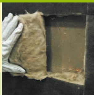
2 Apertura del Ecovent tipo ventana para colocación de la ménsula.
