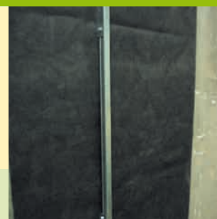
4 Colocación de los montantes verticales de la estructura.
