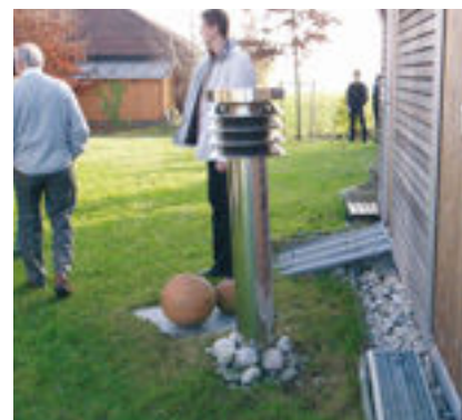
La "nariz" de una vivienda pasiva: conducto de aire para el suministro de aire fresco.
