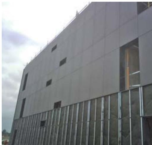
Una fachada ventilada es un sistema de aislamiento continuo el cual está compuesto por una hoja interior sobre la cual se fija a través de un sistema de anclajes la hoja exterior de acabado. El aislante intermedio garantiza la eficiencia energética de la envolvente y el confort de los usuarios.
