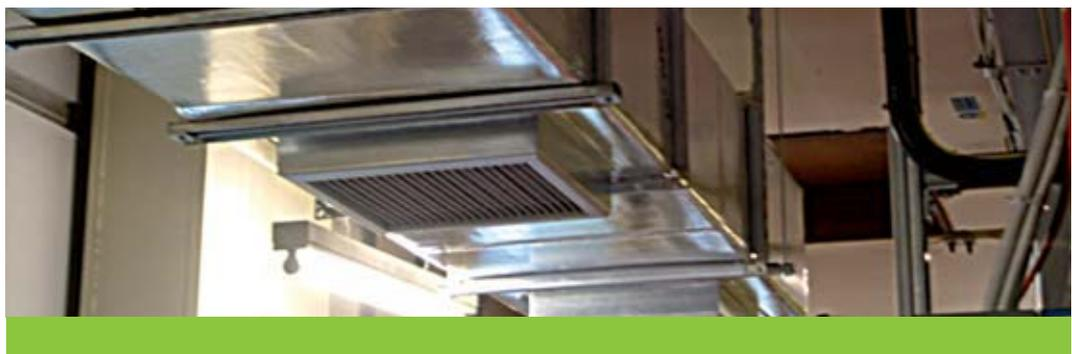
La utilización de elementos separadores tipo sándwich con aislamiento térmico incluido, como es el caso de la Gama **CLIMAVER**, elimina los riesgos de condensaciones, incluso con diferencias notables de temperaturas.
