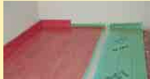
Resulta fundamental aislar acústicamente los cerramientos horizontales de la vivienda, prestando especial atención a que se resuelvan de forma adecuada durante la obra los puentes acústicos.
