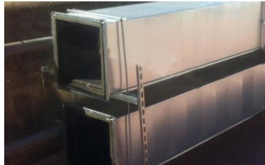
Panel autoportante revestido por una de sus caras por un tejido **Neto** que otorga al conducto metálico una elevada absorción acústica.
