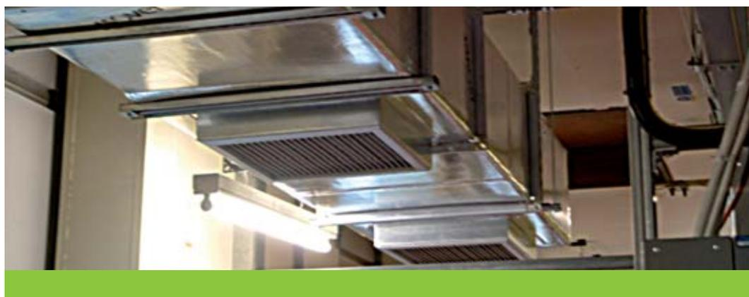
La utilización de elementos separadores tipo sándwich con aislamiento térmico incluido, como es el caso de la Gama **CLIMAVER**, elimina los riesgos de condensaciones, incluso con diferencias notables de temperaturas.
