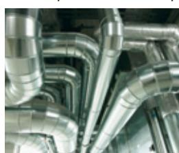
HVAC. Las cubretuberías CLIMPIPE proporcionan altos niveles de aislamiento térmico y previenen la condensación en las tuberías.
