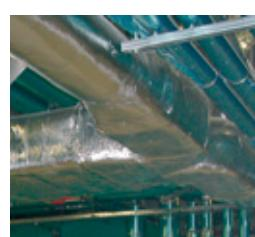
La solución ISOVER para el aislamiento por el exterior de conductos metálicos.
