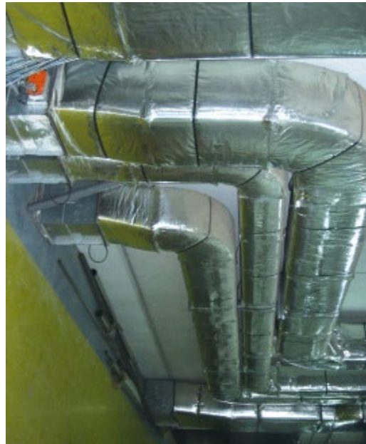
Aislamiento fijado con flejes
