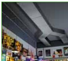
Paneles para la fabricación de conductos autoportantes de distribución de aire en Climatización, fabricados a partir de lana de vidrio, y concebidos para su instalación vista (sin falso techo), conservando unas propiedades óptimas de reacción al fuego, e incorporando en su interior el tejido Neto, para ofrecer elevada atenuación acústica y favorecer su limpieza.
