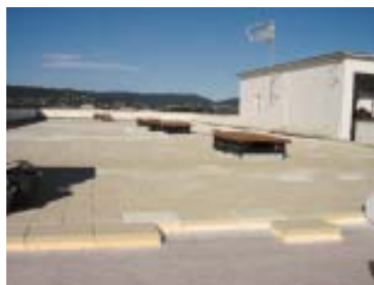
Acabado con Polyfoam Losa
