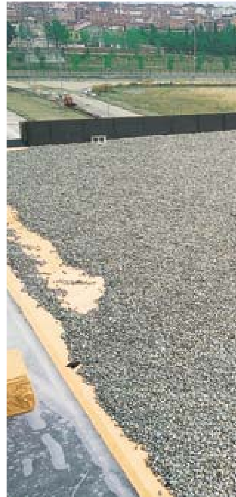
Cubierta invertida. Acabado con grava
