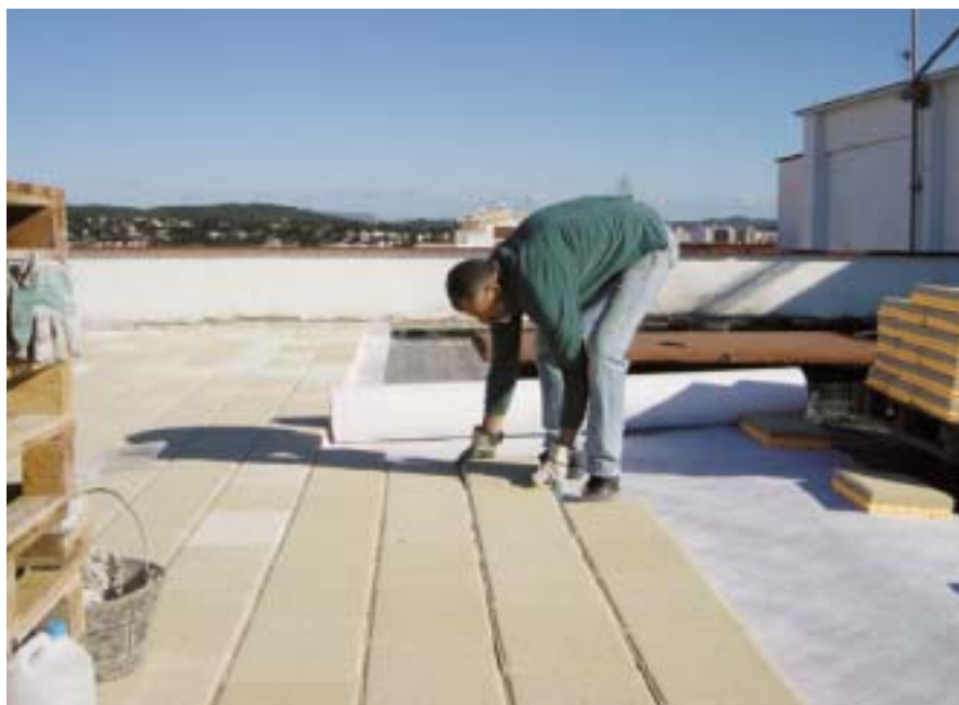
Rehabilitación de cubierta. Lastrado con Polyfoam Losa
