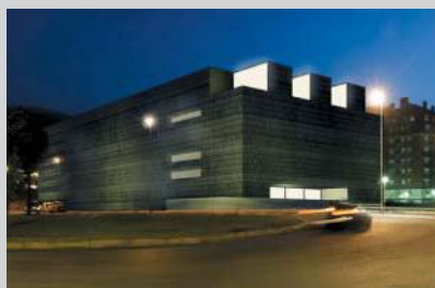
Casa del Deporte y Frontón, Bilbao
