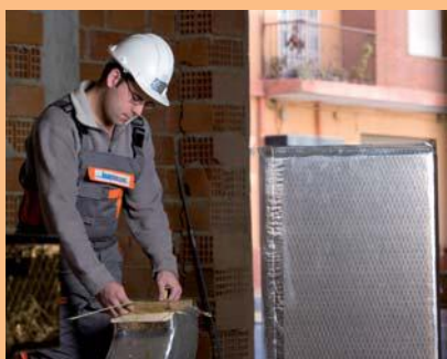
El recubrimiento exterior de CLIMACOUSTIC actúa como barrera de vapor, evitando condensaciones intersticiales en los conductos
