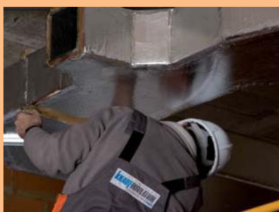
Los conductos CLIMACOUSTIC se instalan en obra mediante accesorios metálicos adecuados a tal fin (perfil U, varillas, pletinas, etc.)
