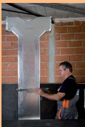
Los mecanizados laterales que vienen realizados de fábrica en los paneles CLIMACOUSTIC posibilitan la perfecta unión entre piezas para la obtención de un tramo de conducto
