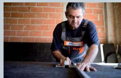
Trazado y corte de un panel CLIMACOUSTIC para la obtención de una pieza
