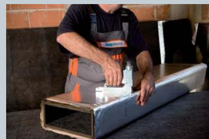
Grapado de la pieza una vez cerrados los cuatro lados del conducto CLIMACOUSTIC de sección rectangular
